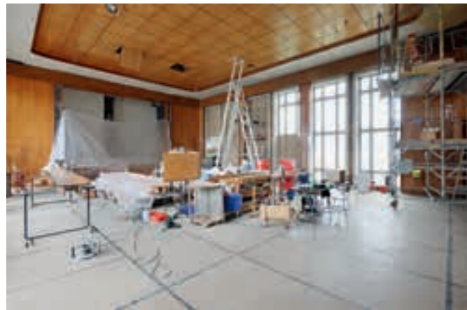
Letzte Instandsetzungsarbeiten (Foto: Philipp Lohöfener © Wüstenrot Stiftung)
