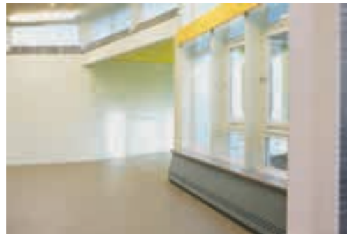
Klassenraum mit Auslässen für die Luftheizung nach der Instandsetzung (Foto: Eva Schwarz © Wüstenrot Stiftung)
