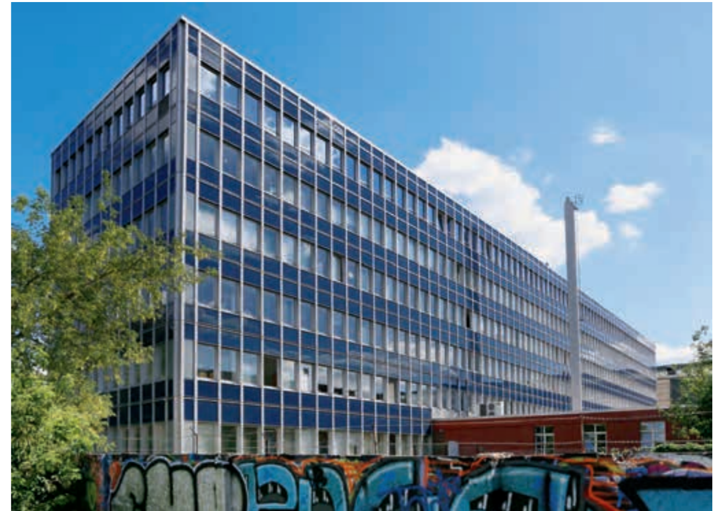
Neubrandenburg, Stahlbetonskelettbau mit Leichtbaufassade
