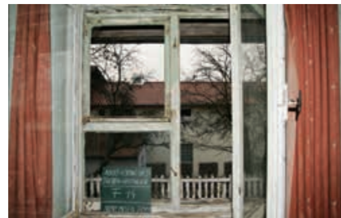
Fensterkonstruktion im Obergeschoss
