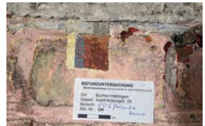
Farbbefunde Oben: Treppenhaus Unten: Farbbefunde am Kamin im Erdgeschoss
