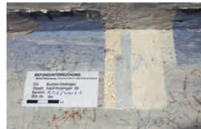
Farbbefunde Oben: Holzeinbauschränke im Erdgeschoss Unten: Übergang Wand – Decke im Erdgeschoss
