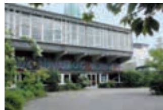
Außenansicht vor der Instandsetzung (Foto © Thomas Knappeide)
