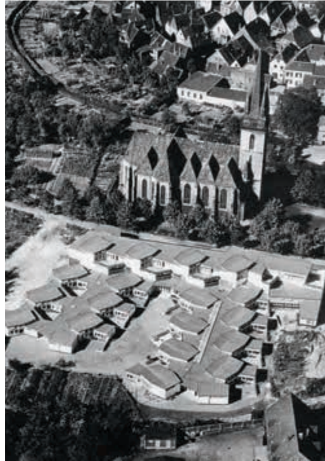
Luftbild 1. und 2. Bauabschnitt um 1962 (Foto: Dieter Storp © Walter Moog)
