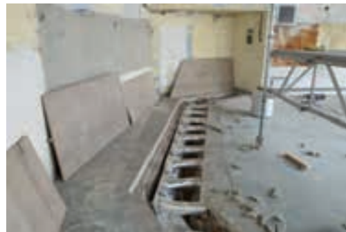
Klassenraum mit Bodenkanal für die Luftheizung während der Instandsetzung (Foto © Spital-Frenking + Schwarz)
