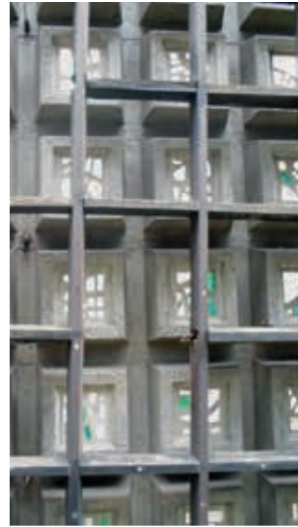
Schadenbilder Holzraster: defektes Holzraster (Foto © Steffen Obermann/ADB)
